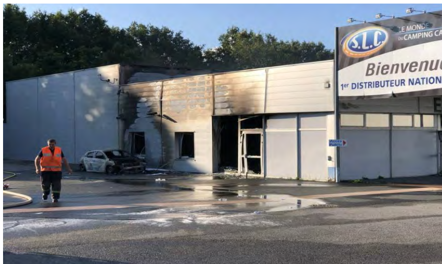
Figure 4 : feu intervenu en août 2021 dans une concession de camping-cars en France à la suite d'un court-circuit lors de la recharge d'un véhicule électrique. En l'absence de borne de recharge, on aperçoit sortant de la fenêtre un câble de rallonge pour la recharge du véhicule. L'incendie a ravagé en grande partie le bâtiment administratif de la société ainsi que des éléments de l'atelier carrosserie
